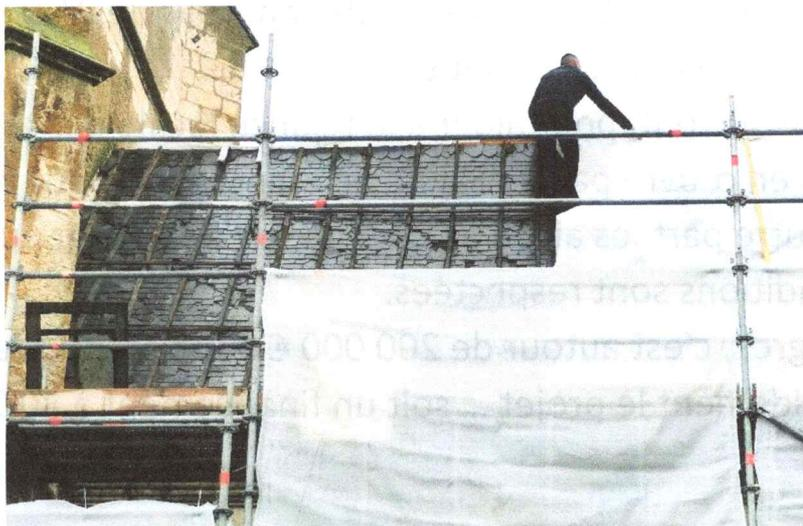
Une particularité, une fois la toiture amiantée retirée, apparaît une 2<sup>ème</sup> toiture avec des ardoises naturelles... les couvreurs dans les années 60/70 ont gagné du temps en ne mettant qu'un latage sur l'ancienne toiture... mais pour nous déjà notre 1<sup>er</sup> avenant...
